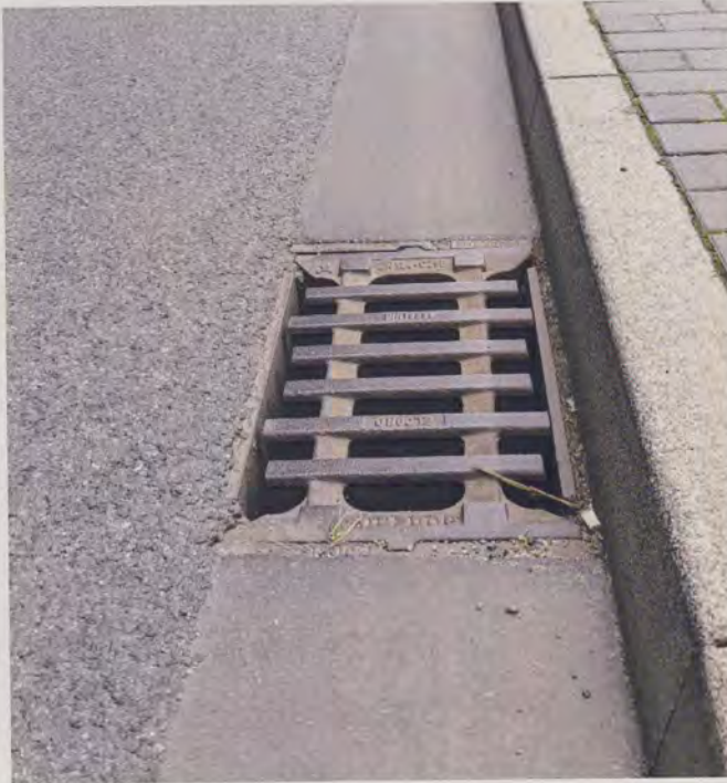
Bild 8: Bordrinne aus Gussasphalt (FGSV 2023b)
