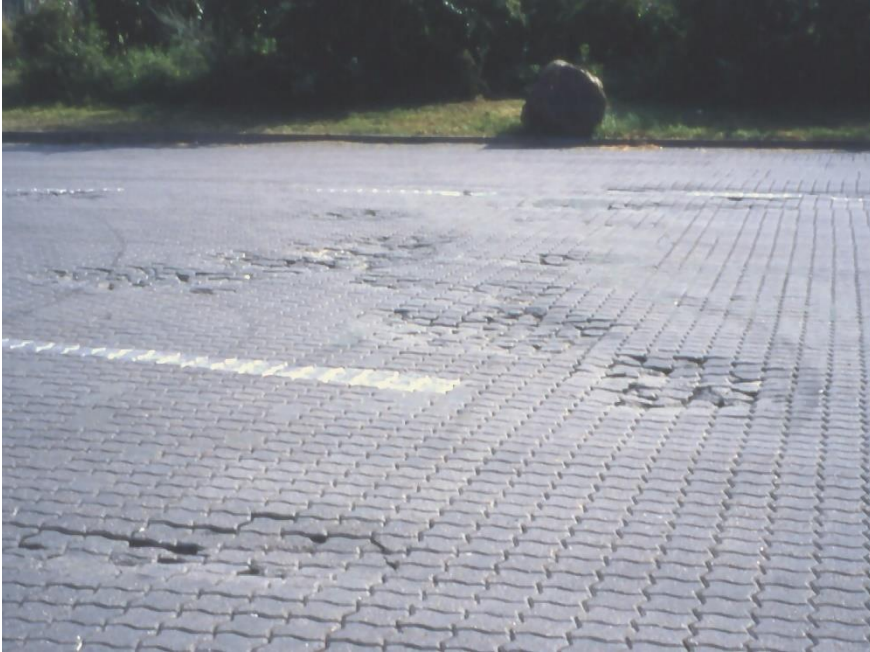
Bild 1: Beispiel für langwellige, muldenartige Unebenheiten in einer Pflasterdecke (Foto: M. Köhler)
