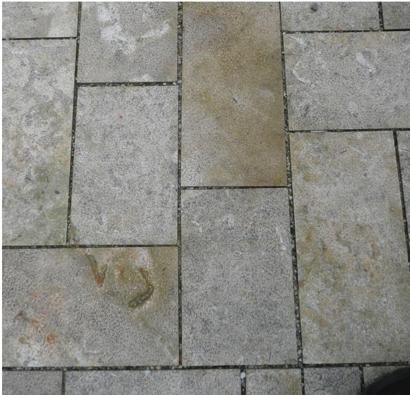
Bild 6: Durch Krönen aufgeraute Natursteinplatten (Foto: B. Burgetsmeier)
