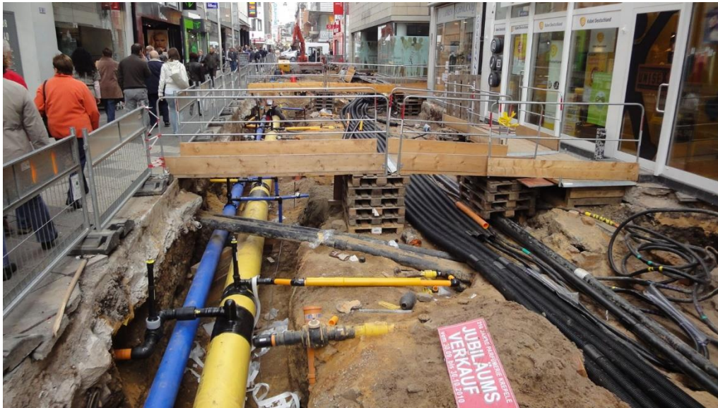
Bild 4: Beispiel für die Anzahl und den Verlauf von Leitungen unterhalb der Tragschichten (Foto: W. Schneider)
