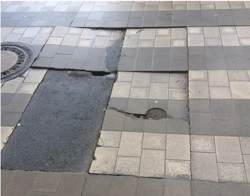
Bild 2: Beispiel für Unebenheiten (Stufenbildung) bei einer Pflasterdecke in gebundener Ausführung (Foto: J. Ludwig)
